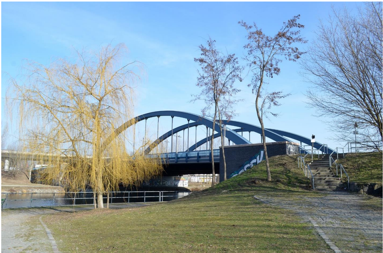
Blick auf die Mörschbrücke über den Westhafenkanal. Bild: SWUP GmbH
