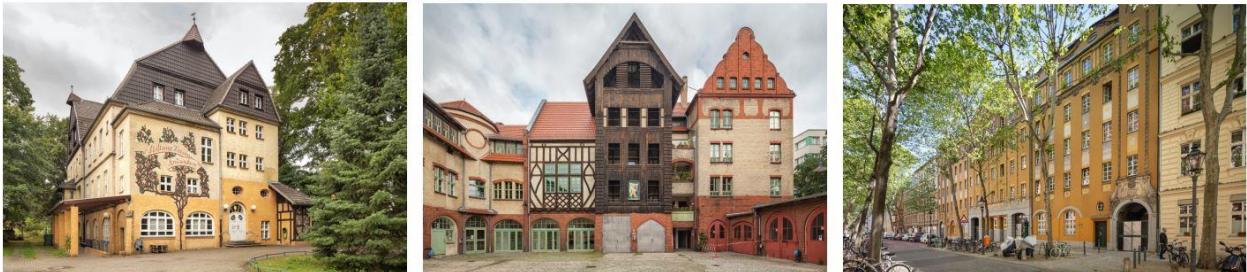
Drei Gebäude von Rudolf Walter, die heute noch existieren: (v.l.) Waisenhaus der Stiftung Luisens Andenken an der Ulmenallee 50, die Feuerwache Alt-Lietzow und das Ledigenheim an der Danckelmannstraße 46-47. Fotos: Sebastian Kringel
