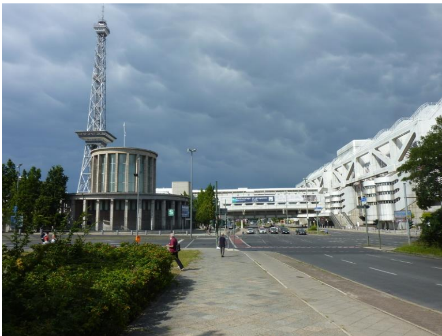
Planfeststellungsverfahren für das Bauvorhaben „Umbau Autobahndreiecks Funkturm“. Bild: BACW
